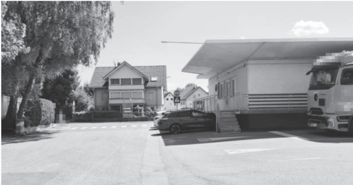
ABB. 35 — Blick A — aus der Blumenaustraße auf die Einmündung: der Kurvenradius ist auf der Gemeindestraße ausgebildet, die Gegenfahrbahn muss mitbenutzt werden.
