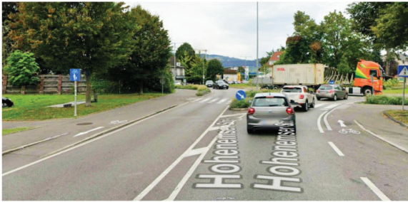
Bereich Engelkreisverkehr - (L203 km 9,300)
