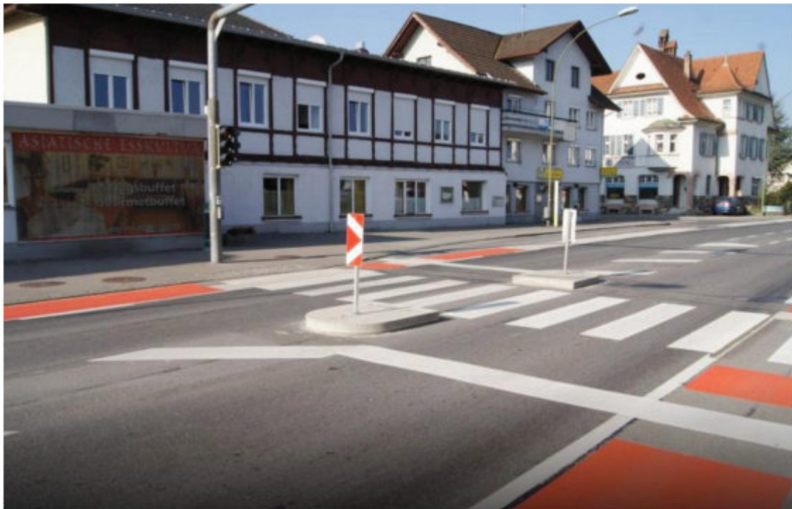
ABB. 16 — Schutzweg Gasthaus Linde 2011, kurz nach Errichtung der Mittelinsel: die Querung ist in zwei Etappen möglich. Quelle: vol.at 3058067.
