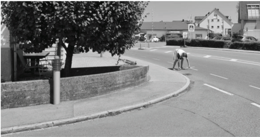
ABB. 42 — Blick A — Kurvenbereich Quellenstraße: der 1,15 m breite Mehrzweckstreifen wird von Kfz zur Optimierung des Kurvenradius mitbenutzt.
