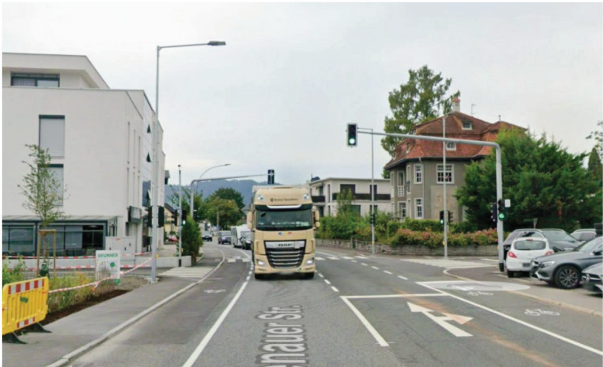
ABB. 48 — Der Knoten Raiffeisenstraße nach dem Umbau: der Radfahrstreifen ist durchgehend erkennbar und eindeutig zugeordnet. Quelle: Google Streetview 2024.
